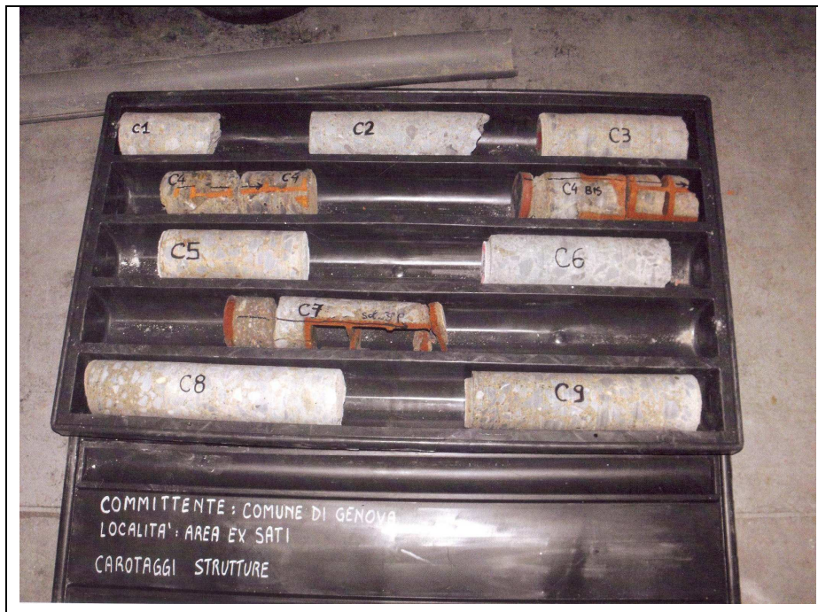
Figura 3 : carotaggi sulle strutture
