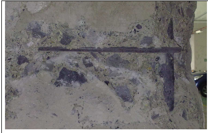
Figura 2 : saggio d'armatura sul pilastro al piano terra
